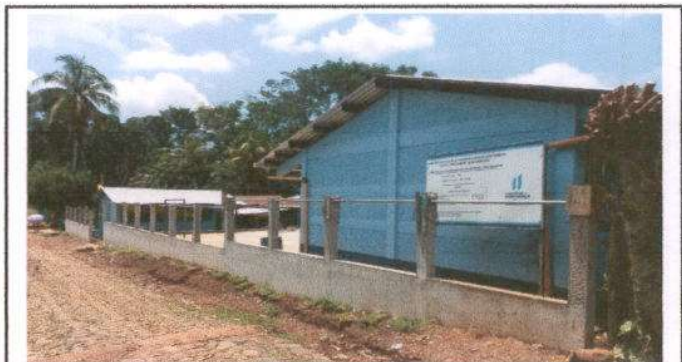
Foto 6: Sustrucción de muro perimetral
