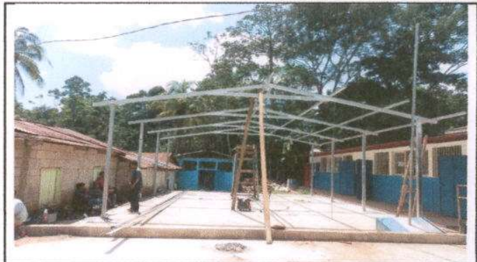
Foto 2: Sustrucción de estructura de soporte de madera, por metal
