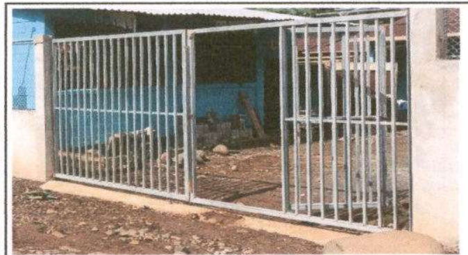
Foto 3 Sustrucción de portón por metal
