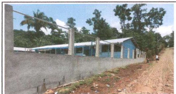
Foto 5: Reparación de muro perimetral de bloc con tubo hg y malla galvanizada, soleras intermedias y columnas
